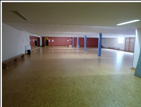
Bild 11: Untergeschoss. Decke Gipslochdecke (M15 – kein Asbest) Wände: Sichtmauerwerk mit Farbanstrich, Fußboden: OSB auf Holzkonstruktion (neuartig) Mineralwolle im Fußbodenaufbau (unterstellt KMF, K1B-Material)
