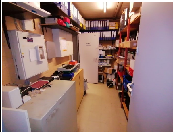
Bild 7: Archivraum im Erdgeschoss. Bodenbelag als Flexplatten, unterstellt asbesthaltig .
