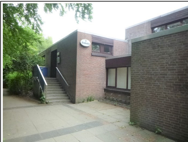
Bilder 1 und 2: Vereinsgebäude in Massivbauweise, Sichtmauerwerk, Flachdachkonstruktion wetterbedingt nicht geöffnet) Mineralwolldämmung (unterstellt KMF, K1B-Material) in der Deckenkonstruktion. FH-Tür, unterstellt asbesthaltig /KMF-haltig.
