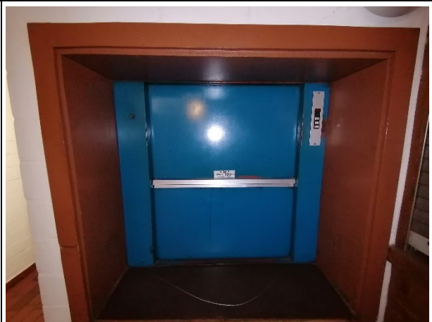
Bild 10: Küche, Obergeschoss, Warenaufzug im Gebäude, Altbestand, ggf. noch asbesthaltige Bestandteile.
