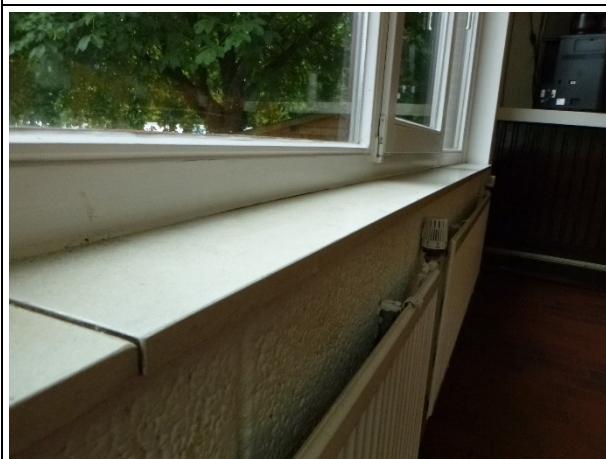
Bild 5: Fensterbänke als Faserzement (M14 - asbesthaltig )
